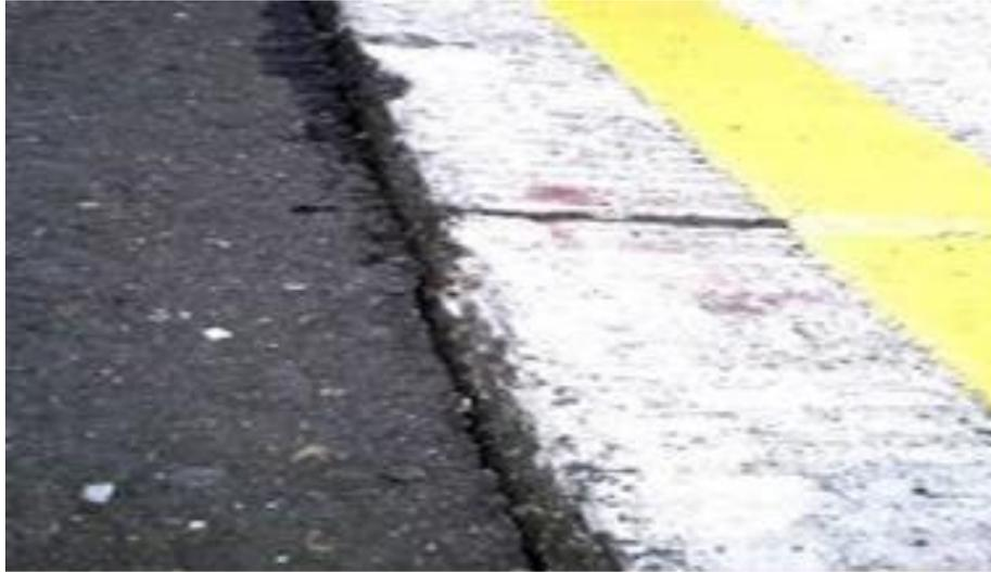
Gambar II.6 Retak sambungan pelebaran jalan
