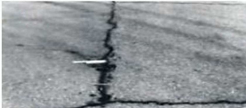
Gambar II.5 Retak Sambungan jalan
