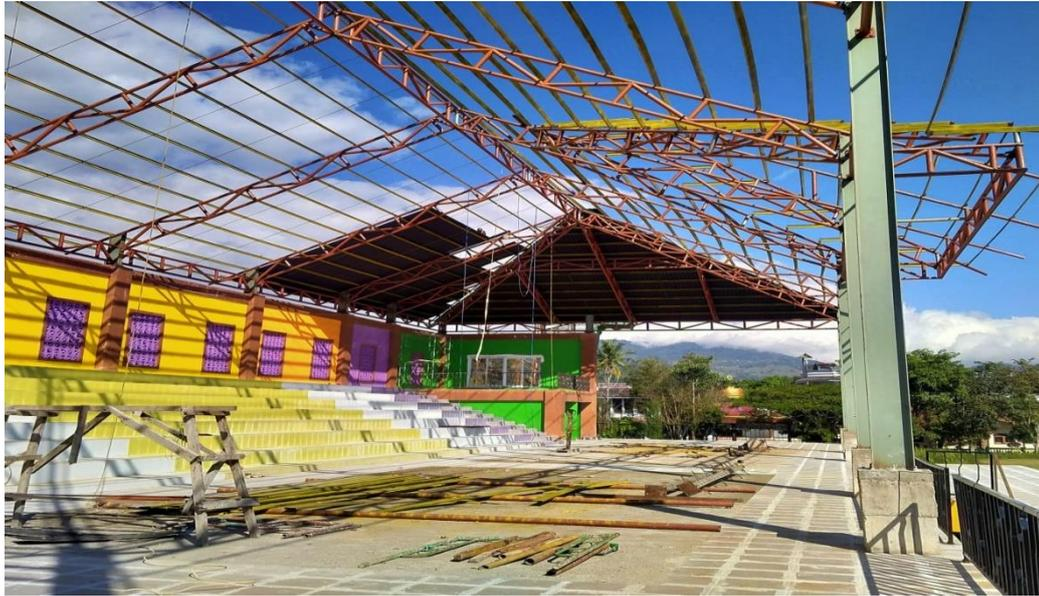
**Gambar 1.** Pekerjaan Rangka Atap
