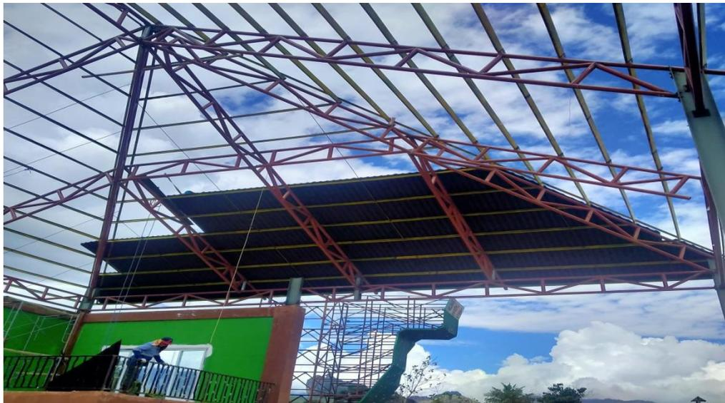
**Gambar 2.** Pekerjaan Rangka Atap
