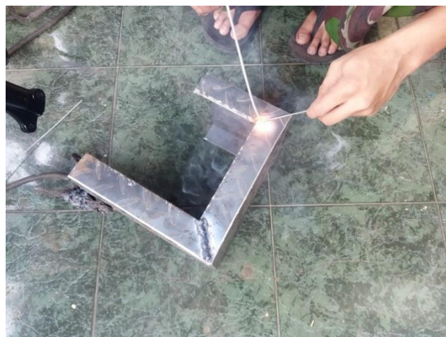
Gambar 4.11 Pengelasan besi plat sebagai dudukan baterai
