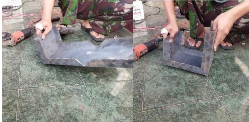
Gambar 4.10 Penekukan besi plat sebagai dudukan baterai
