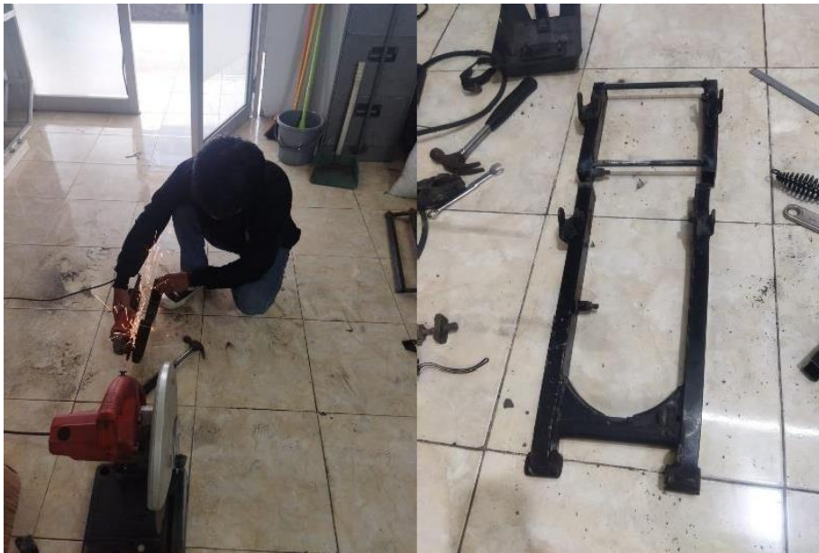
Gambar 4.2 Pemotongan lengan ayun (swing arm)
