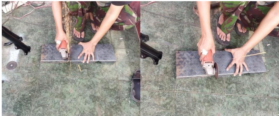
Gambar 4.9 Pemotongan besi plat sebagai dudukan baterai
