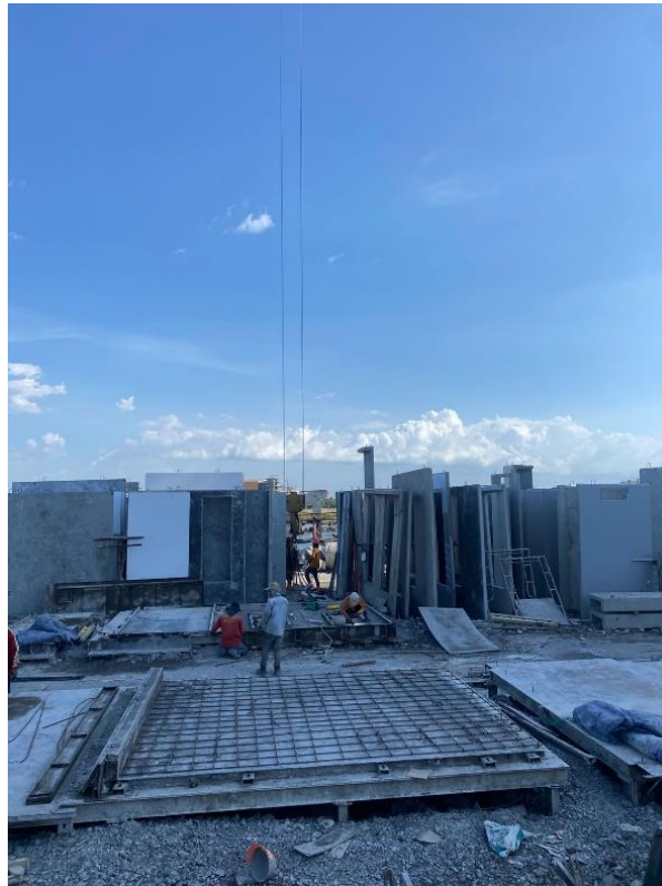
Gambar 3 Pengangkatan Dinding Precast Menggunakan Chainblok
