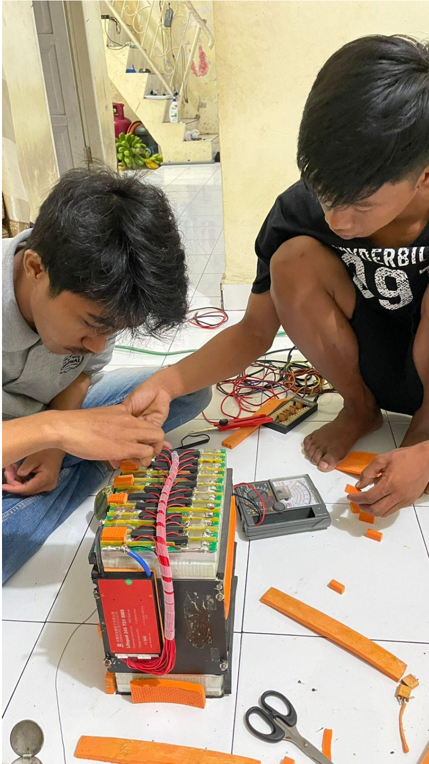
Gambar 3.. pemasangan rangkain seri baterai
