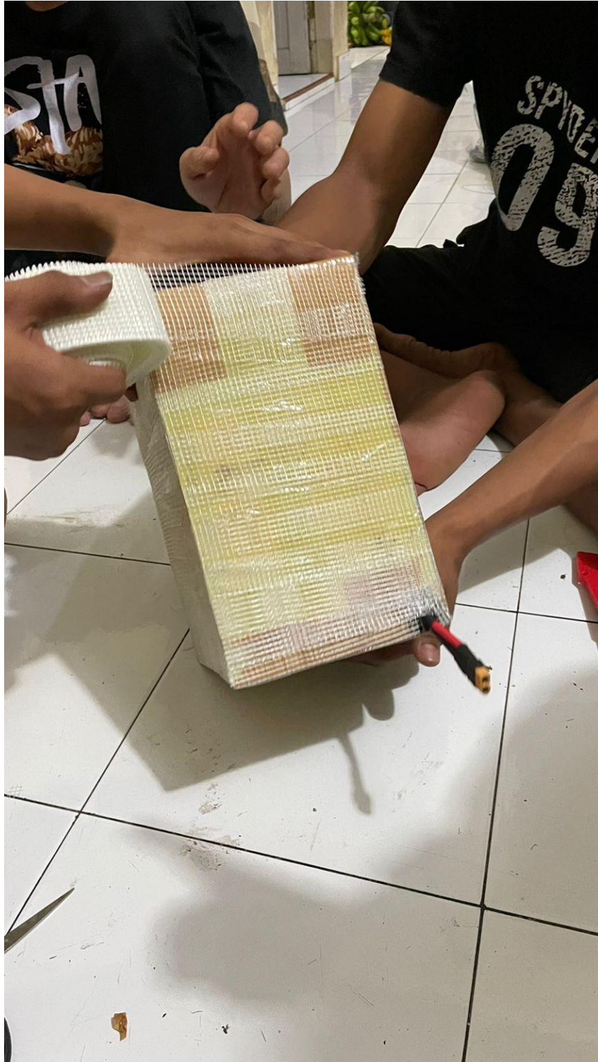
Gambar 1 dan 2. Pemasangan isolasi gypsum
