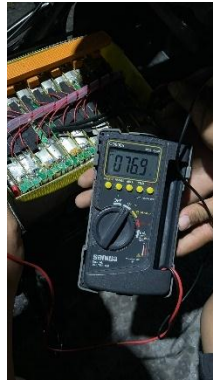
Gambar IV. 13 Sisa daya setelah masa percobaan baterai
