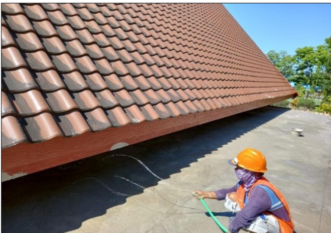
Perawatan plat beton bangunan
