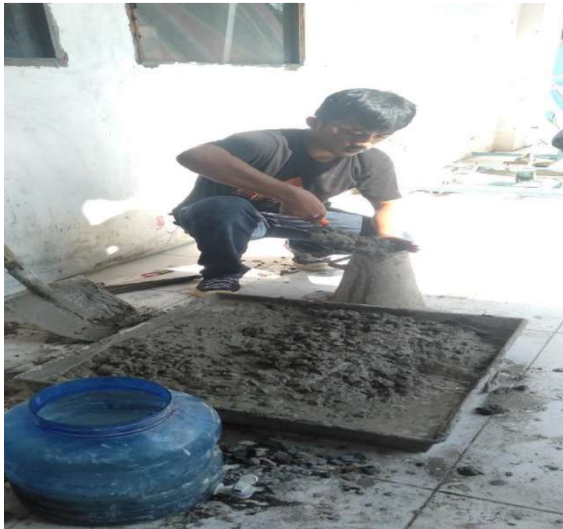
Proses Pencampuran Beton
