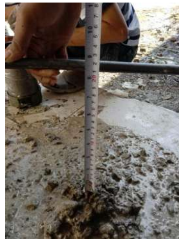
Gambar IV.7 Pengujian Slump Variasi Fly Ash 25%
