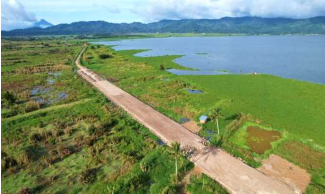
Lampiran 1: Pekerjaan Timbunan Tanah Dipadatkan Lokasi A-1 Telah Selesai
