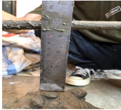
Gambar IV.3 Pengujian Slump Beton
