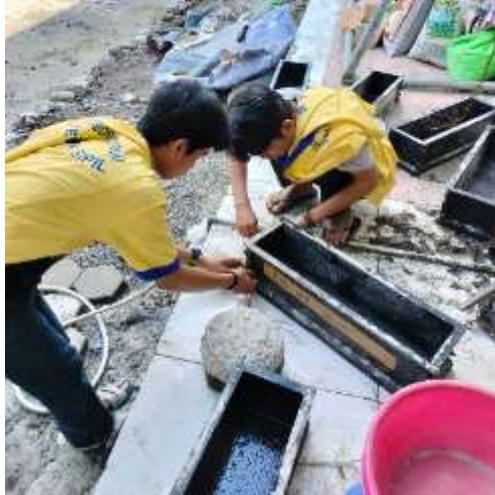
7. Proses pencampuran, uji slump dan pengecoran
