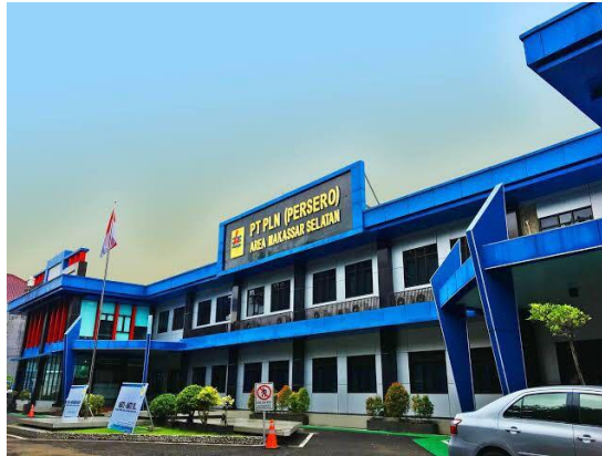
Gambar 4.1 Profil Perusahaan PT. PLN (Persero) UP3 Makassar Selatan
