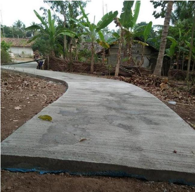
**Gambar 7.2** Perkerasan Kaku di Pulau-Pulau 3T Indonesia
