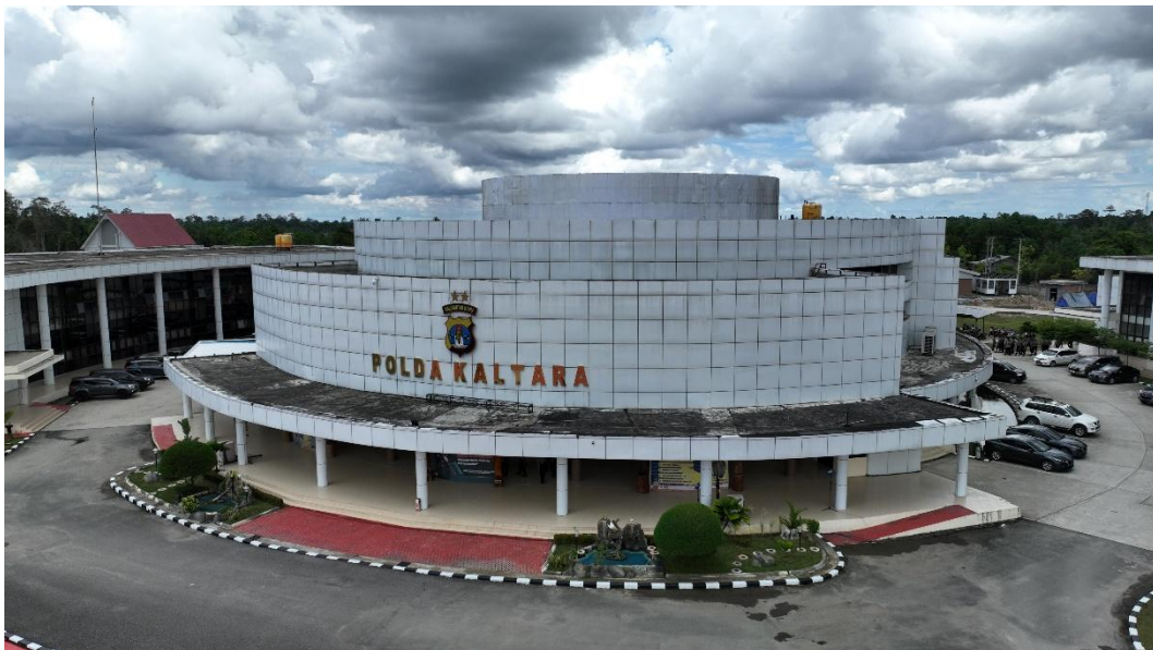
Gambar gedung Polda Kaltara
