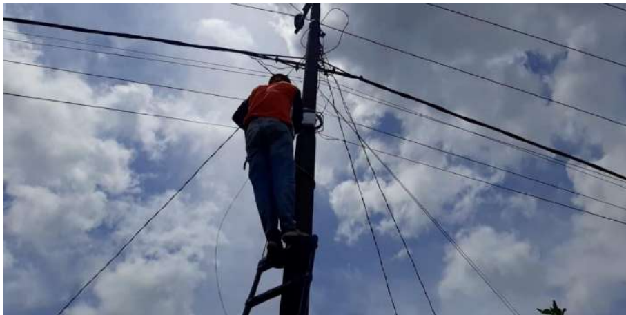
Gambar 7. Proses pemasangan kabel Fiber Optic pada ODP
