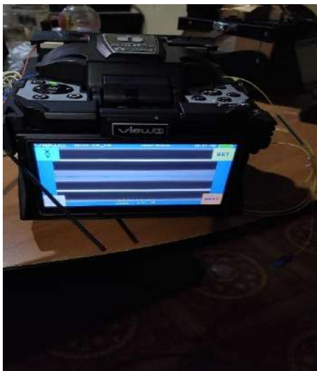
Gambar 3. Proses penyambungan menggunakan alat sambung splicer
