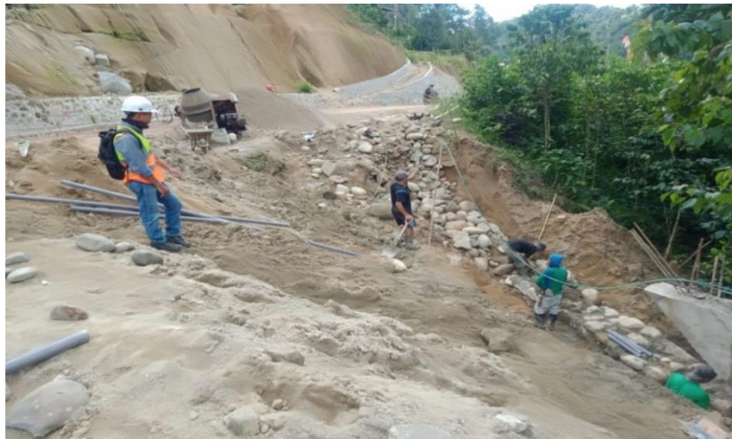
Gambar 4 Pekerjaan Dinding Penahan
