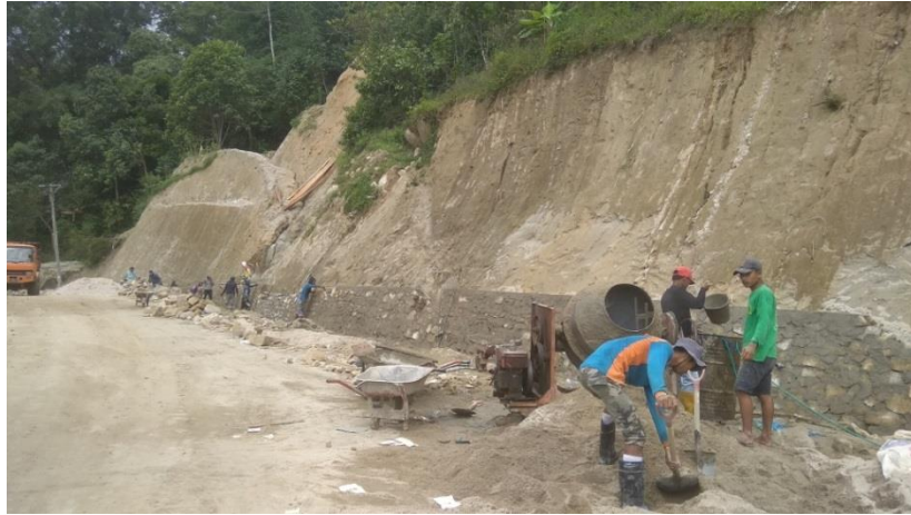
Gambar 3 Pekerjaan Dinding Penahan
