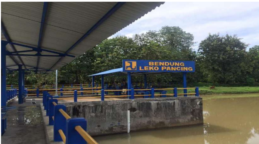
Gambar A 2 Tampak dalam Bendung Leko Pancing
