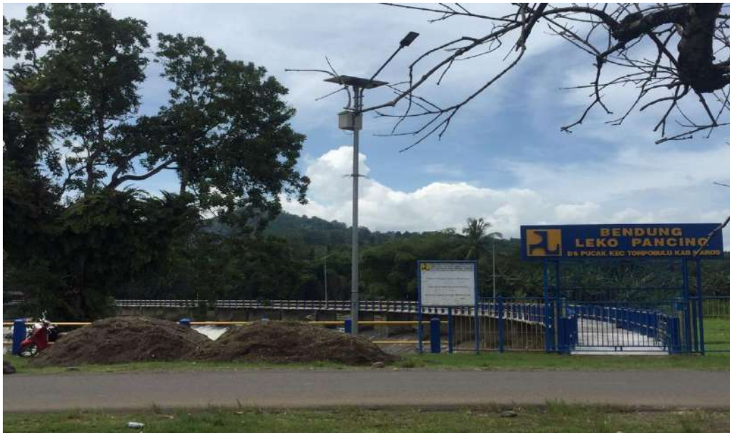
Gambar A 1 Tampak luar Bendung Leko Pancing
