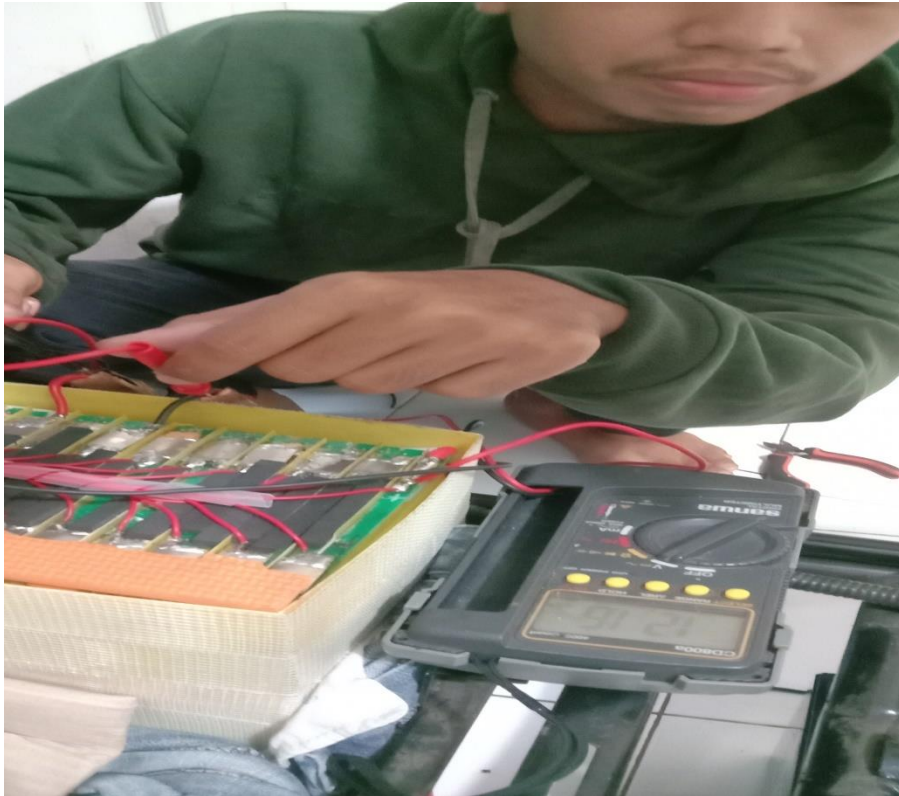
Pengecekan baterai per sel untuk mengetahui berapa ampere per sel nya
