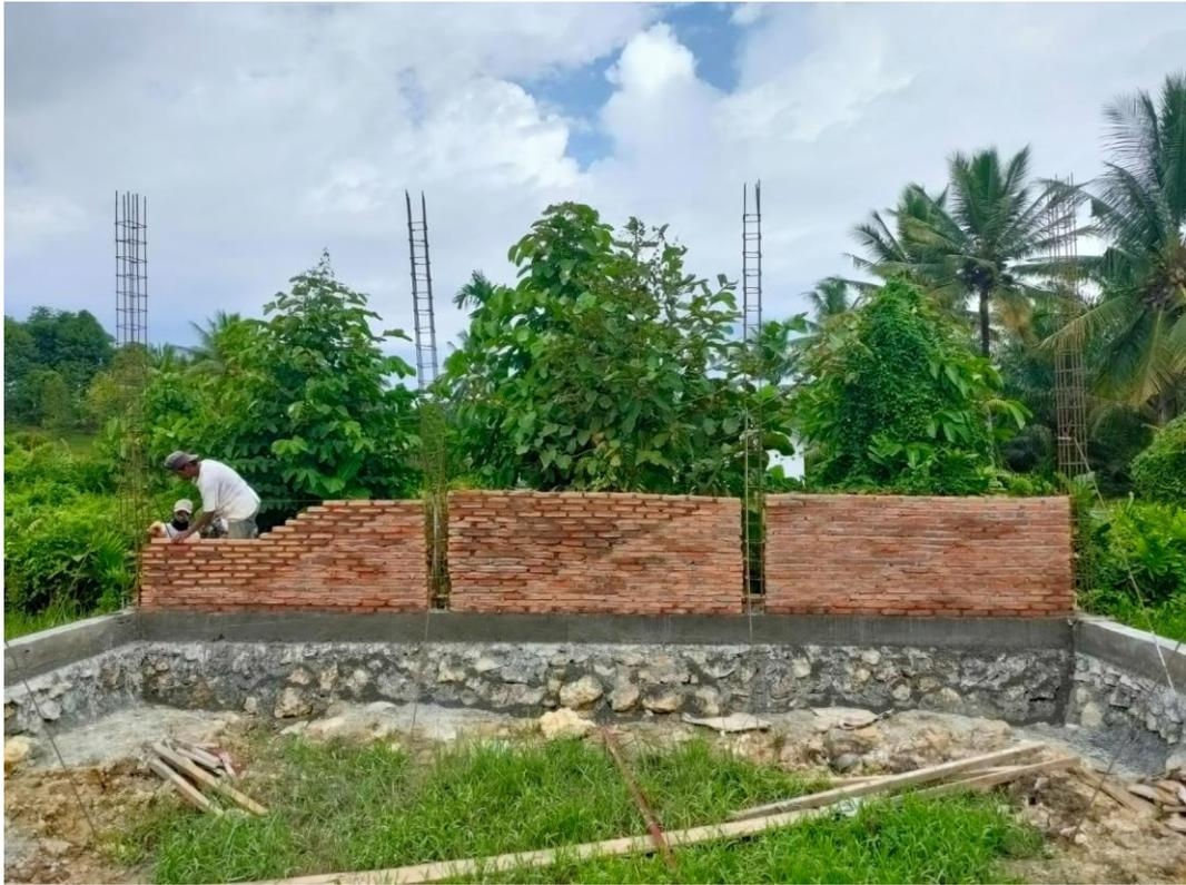
Gambar 4: Pemasangan batu bata merah
