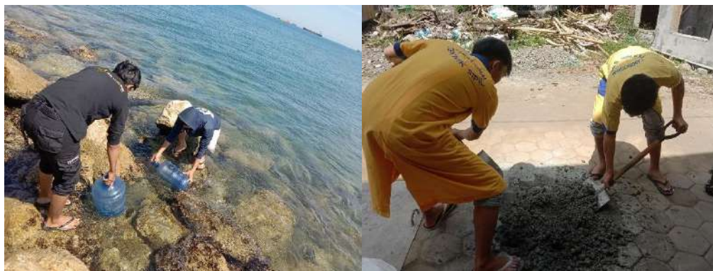
Pengambilan air laut dan pencampuran beton
