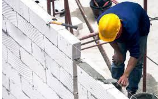
Gambar II.3 Pemasangan Bata Ringan (bildeco.com)
