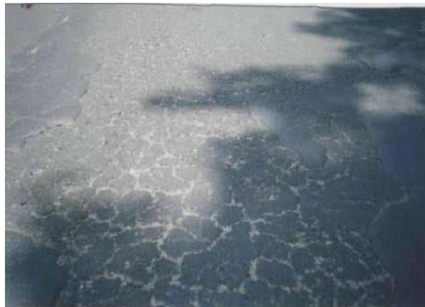
Gambar II. 12 Raveling/Pelapukan
