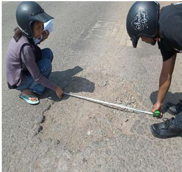
Survey Kondisi Perkerasan Jalan
