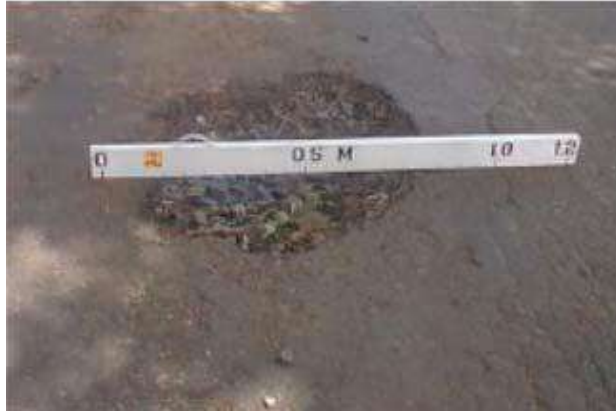
Gambar II. 10 Pothole (Lubang)
