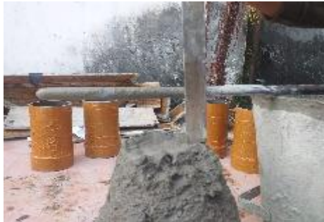
Uji Slump Test
