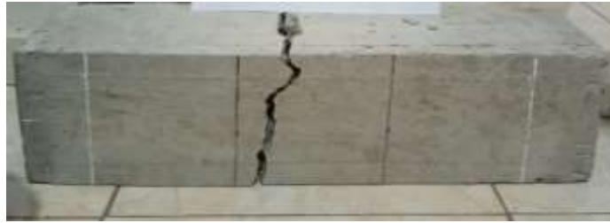
Gambar IV. 7 Pola Retak Balok Beton Normal 1
