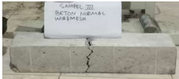
Gambar IV. 17 Pola Retak Benda Uji Balok Beton Normal Wiremesh 3
