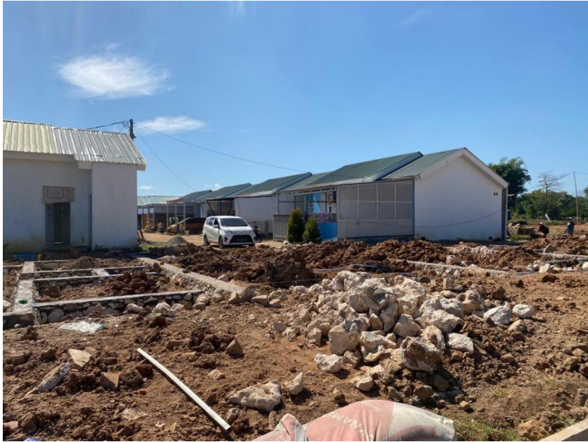
Gambar: Pekerjaan Pondasi
