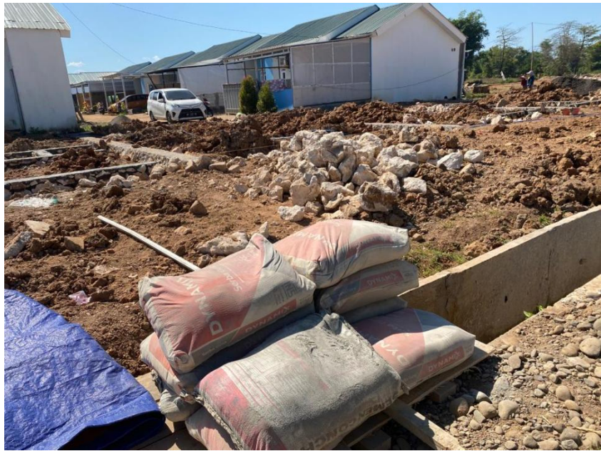
Gambar: Pekerjaan Pondasi
