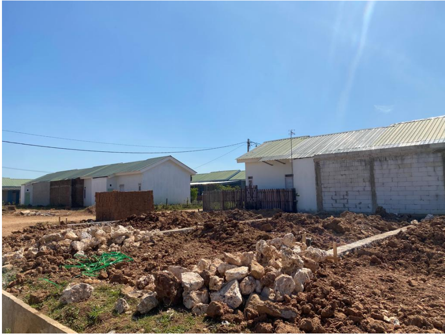
Gambar: Pekerjaan Pondasi
