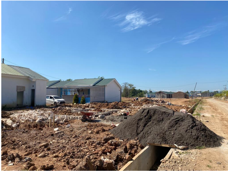
Gambar: Pekerjaan Pondasi
