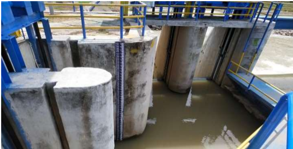
Gambar 4. Pintu Intake Bendung Bantimurung
