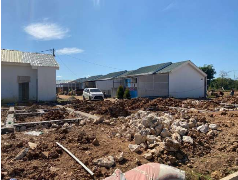
Gambar 3: Pekerjaan Pondasi
