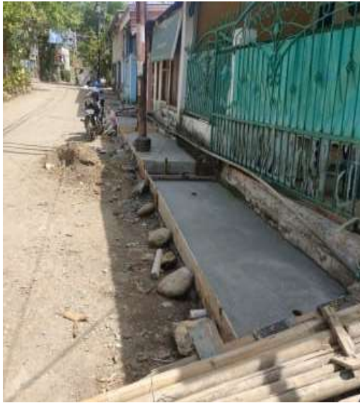
Gambar 5.1 Pekerjaan Pengecoran Plat
