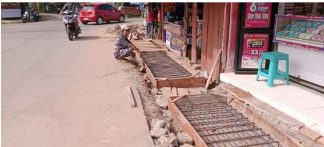
Gambar 4.2 Pekerjaan Pembesian Plat
