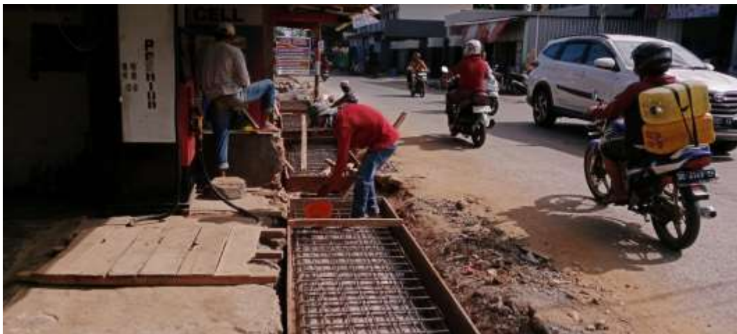
Gambar 4.1 Pekerjaan Pembesian Plat
