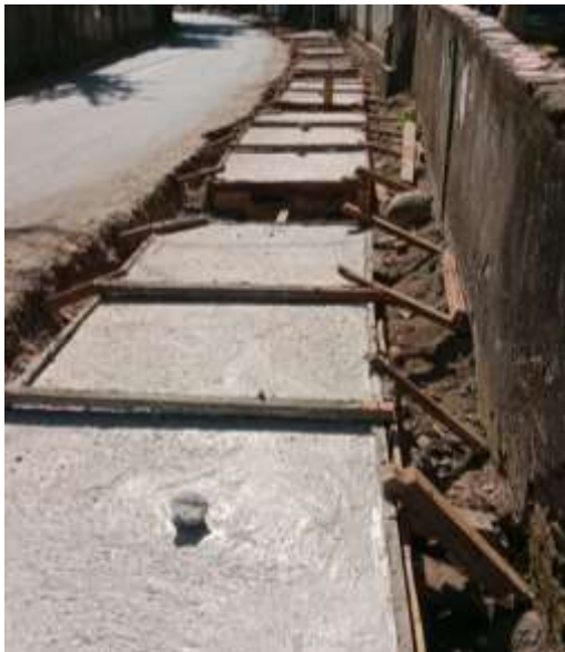
Gambar 5.2 Pekerjaan Pengecoran Plat
