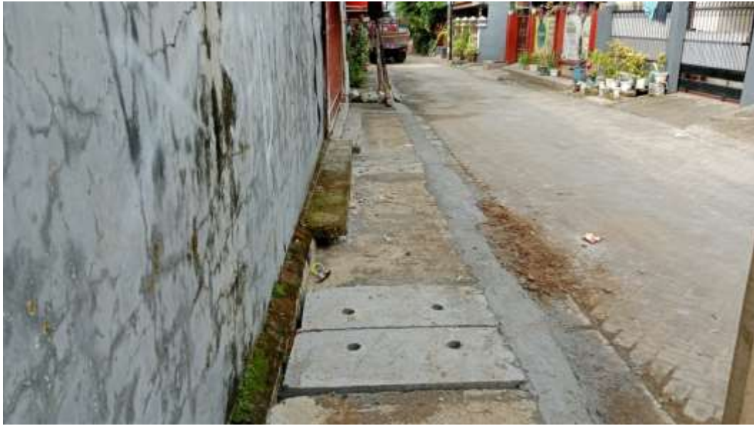
Gambar 6.1 Pekerjaan Pemasangan Cor Mainhold
