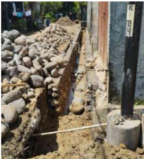
Gambar 2. Pekerjaan Pemasangan Batu Kali Drainase
