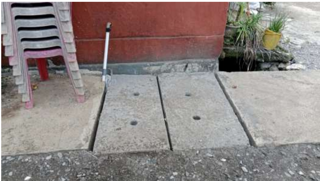
Gambar 6.2 Pekerjaan Pemasangan Cor Mainhold
