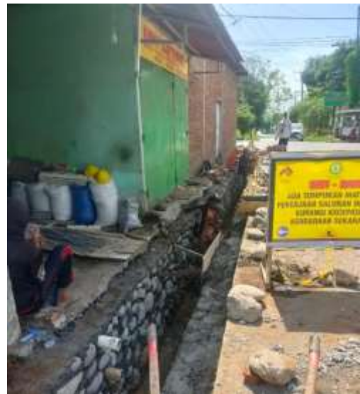
Gambar 2. Pekerjaan Pemasangan Batu Kali Drainase
