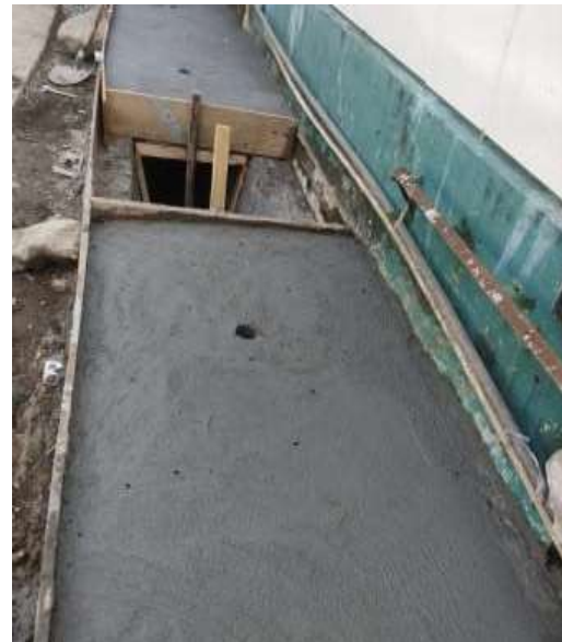
Gambar 5.2 Pekerjaan Pengecoran Plat
