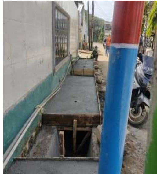
Gambar 5.1 Pekerjaan Pengecoran Plat
