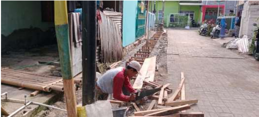
Gambar 3. Pekerjaan Pembuatan Bekesting Plat
