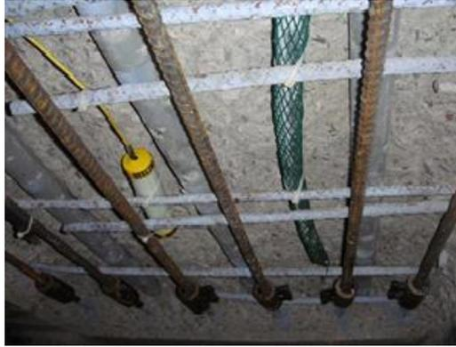
**Gambar 4.4** Anoda Seng Diskrit (Dibungkus dengan Jaring Hijau) dalam Perbaikan Dek Beton. Perangkat dengan Kabel Timah Kuning Adalah Elektroda Referensi Permanen.
